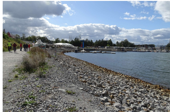
Foto 2: Uferbereich an der Südböschung des Geierswalder Sees, an dem die Terrasse mit dem Freisitz geplant ist
